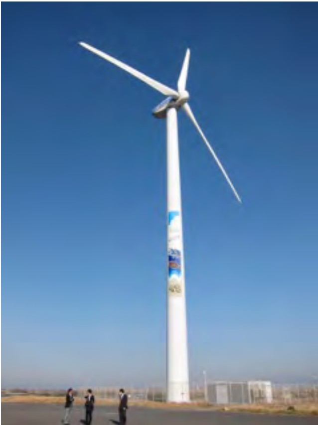
茨城県はさき漁協が設置した風力発電施設：2013年八木信行撮影。
