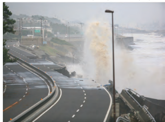
図2 西湘バイパスの被災時の様子
